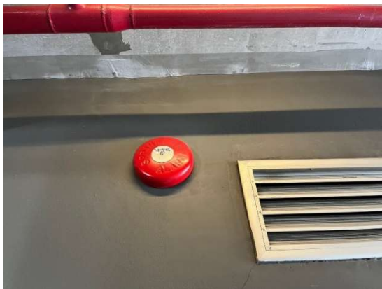
รูปที่ 55 กริ่งสัญญาณเตือนภัย (Alarm Bell)
