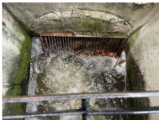
รูปที่ 34 ตะแกรงดักขยะในบ่อตรวจคุณภาพน้ำทิ้ง
