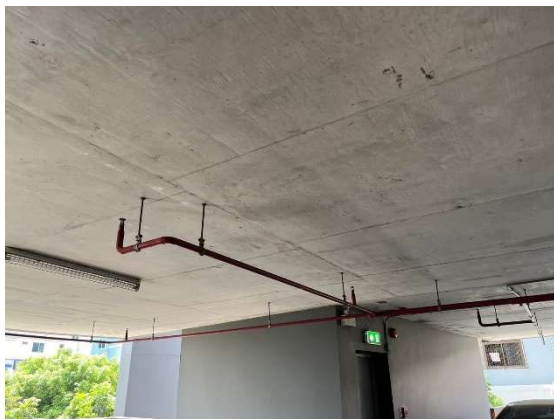
รูปที่ 48 ระบบหัวกระจายน้ำดับเพลิงอัตโนมัติ
