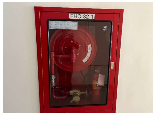
รูปที่ 46 ตู้เก็บสายฉีดน้ำดับเพลิงพร้อมอุปกรณ์ (Fire Hose Cabinet: FHC)
