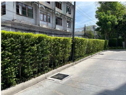
รูปที่ 66 ตะแกรงครอบรูระบายน้ำทิ้ง
