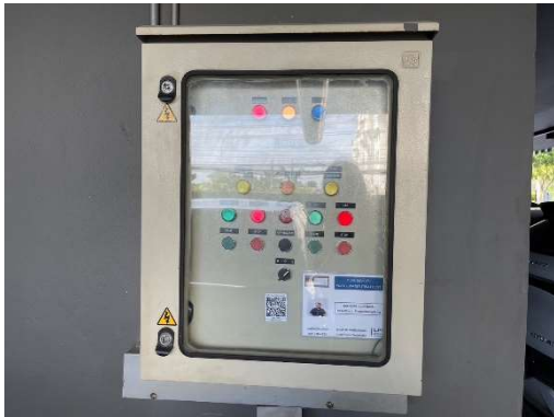
รูปที่ 13 ตู้ควบคุมระบบบำบัดน้ำเสีย
