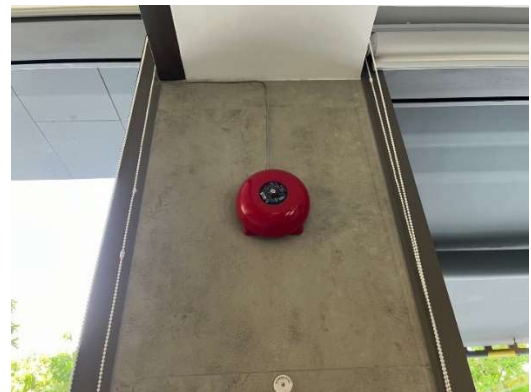
รูปที่ 55 กริ่งสัญญาณเตือนภัย (Alarm Bell)
