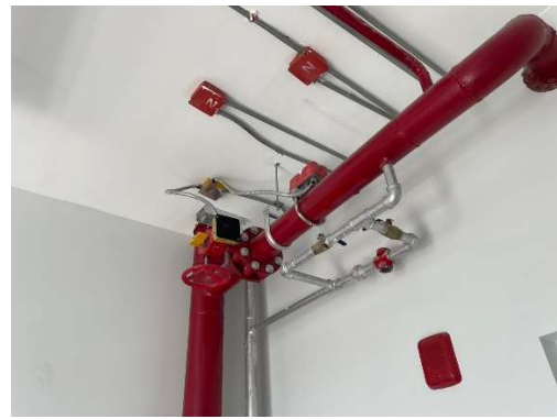
รูปที่ 44 ระบบท่อยืน (Stand Pipe)
