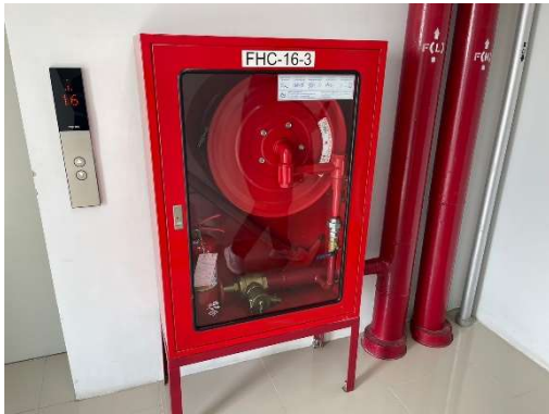
รูปที่ 44 ระบบท่อยืน (Stand Pipe)
