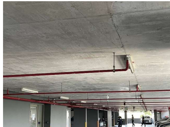
รูปที่ 48 ระบบหัวกระจายน้ำดับเพลิงอัตโนมัติ
